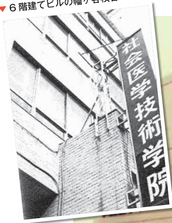
▼6階建てビルの幡ヶ谷校舎
